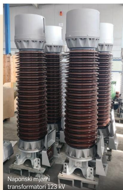
Naponski mjerni transformatori 123 kV
