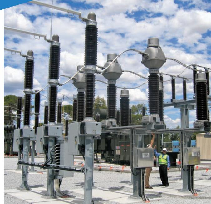
Mjerni transformatori KMT-a ugrađeni u trafostanicu u Australiji
