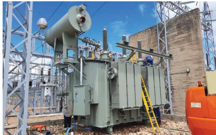
Ugradnja D&ST-ovog transformatora snage 63 MVA u TS Garrafe
