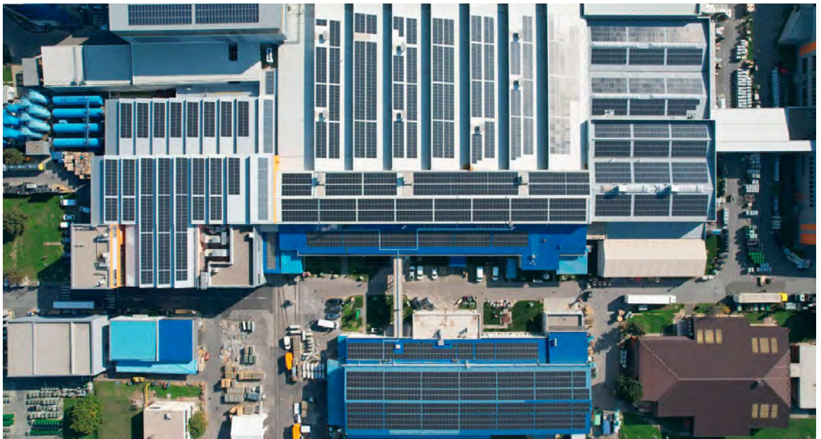
Fotonaponska elektrana na lokaciji KONČAR – D&ST
