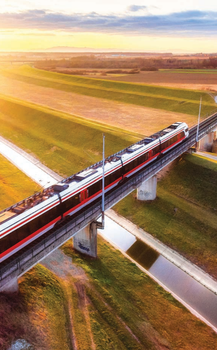
Niskopodni elektromotorni vlak
